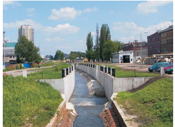
Niedawno wybetonowana Rawa znów ma wyglądać jak rzeka.
