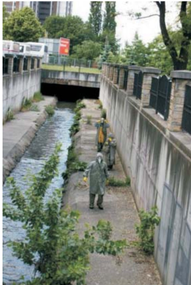
Wyjście z tunelu biegnącego pod ulicą Sokolską
