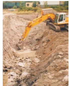
Usuwanie odpadów płynnych ze zwałowiska nr 3. Lipiec 2003 r.
