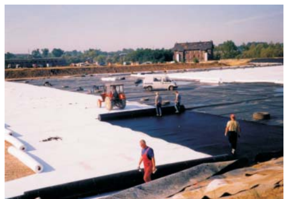
Układanie geowłókniny i geomembrany HDPE w kwaterze K4 CSO. Sierpień 2004 r.
