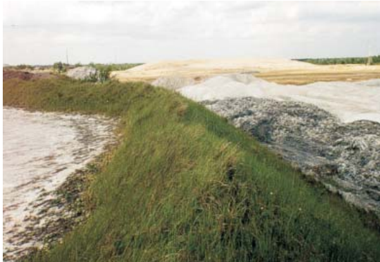
Widok na wypełnioną kwaterę nr 1 CSO. Na pierwszym planie zwałowiska nr 5 i 7. Marzec 2001 r.
